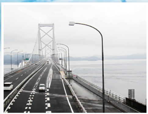
明石海峡大橋
