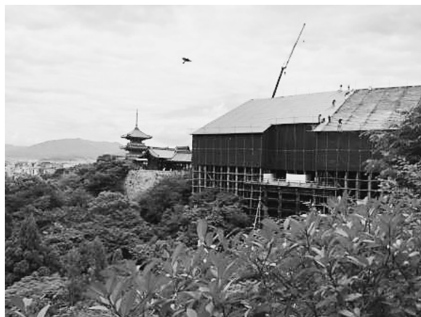
清水寺 平成の大修理
